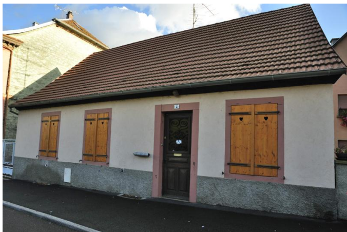
Le 2 rue de l'École, futur presbytère catholique. PHOTOS DNA - B.L.S.
